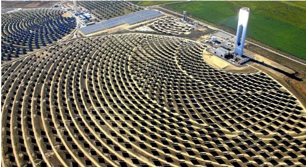
Figura 27: Planta termoelectrica Solucar (Abengoa), con sistema de torre central (Sevilla).
