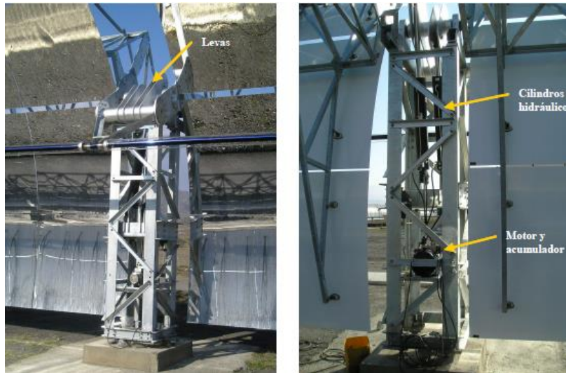
Figura 30: Sistema de seguimiento solar de un CCP.
