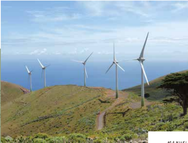
Parque eólico de El Hierro. Carlos Teixidor Cadenas, 2014
